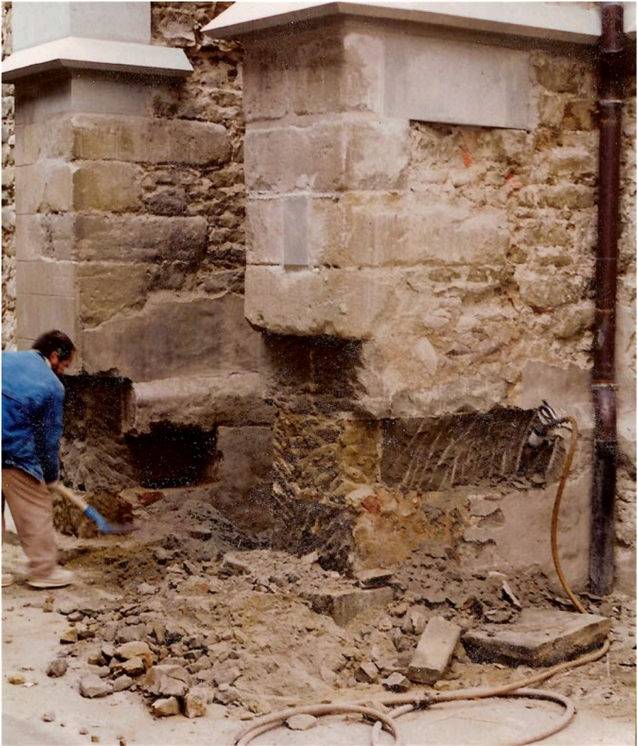
Dieses Foto macht den Aufwand der Instandsetzung deutlich
