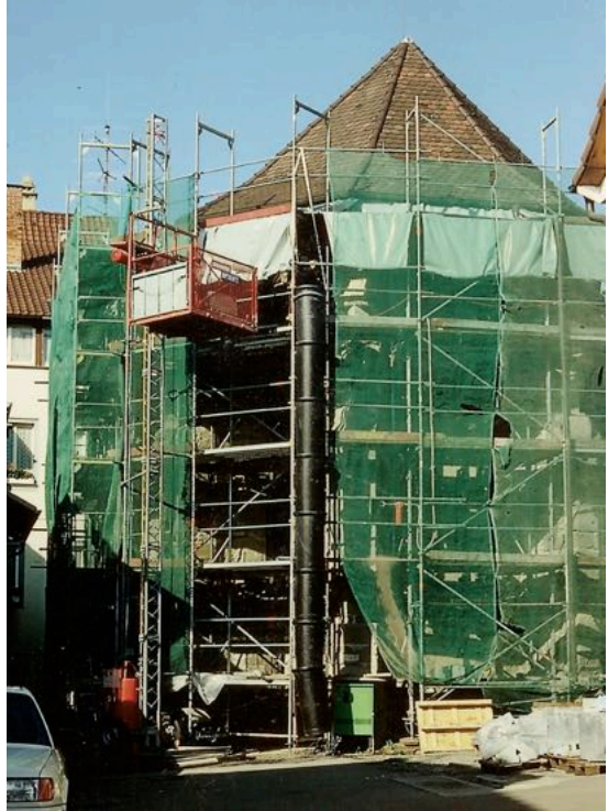
Die eingerüstete Kirche
