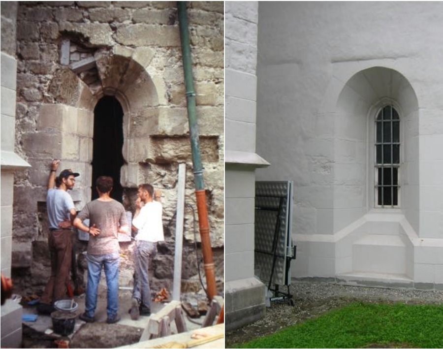
Arbeiten im Bereich der Sakristei, vorher und nachher
